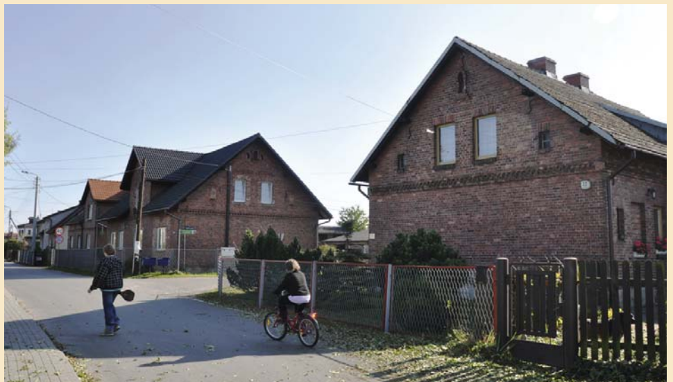
Domy kolejarzy z lat 30. ubiegłego wieku
