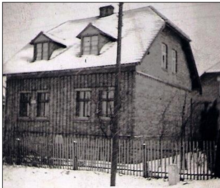
Fot. Dom Speków po rozbudowie – 1954 6
