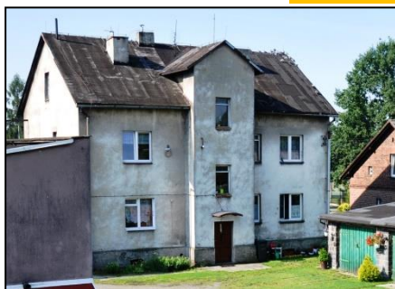
Fot. „Hanelówka” po przebudowie z 1969 roku
