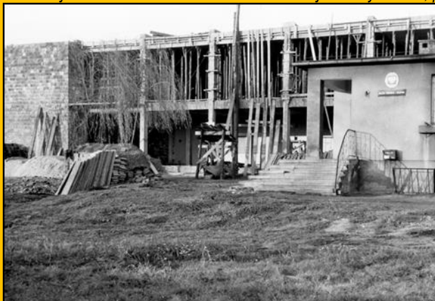
Fot. Rozbudowa WDK w latach 1973-1975
