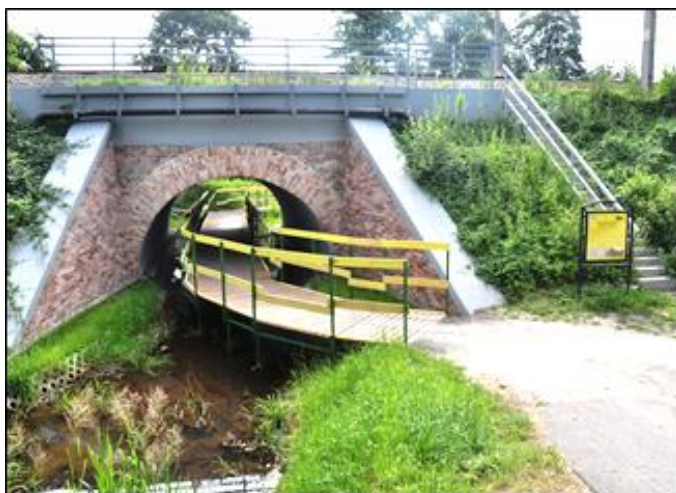
Fot. Kładka i most po remoncie – maj 2018r
