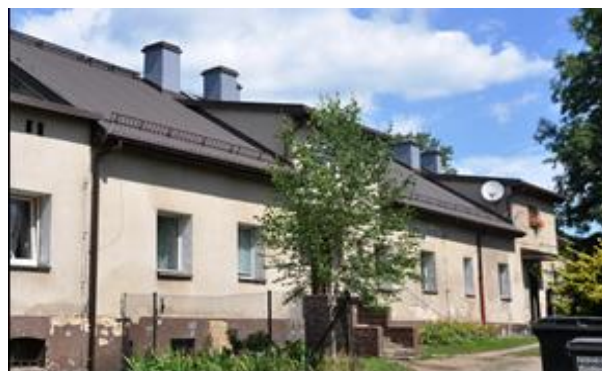
Fot. Po przebudowie dachu- czerwiec 2018
