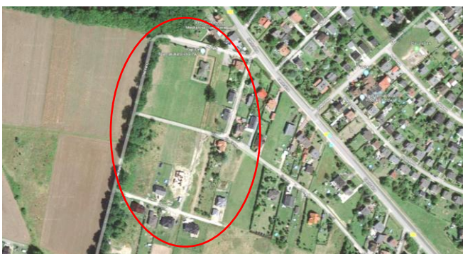
Fragment ulicy Na Kąty objęty budową kanalizacji w 2019r
