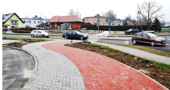
Zdjęcie: Ścieżka pieszo rowerowa w kierunku Centrum
