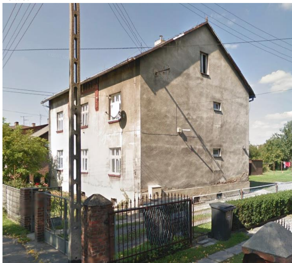
Zdjęcie tzw. „Hanelówki” przed termomodernizacją
