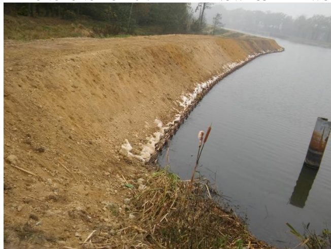
Zdjęcie: Fragment grobli zbiornika środkowego po renowacji
