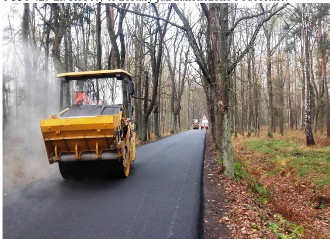
Zdjęcie: Roboty budowlane na ul. Przemysłowej
