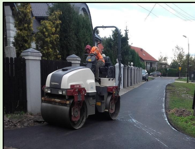
ul. Kobiórska odcinek zachodni
