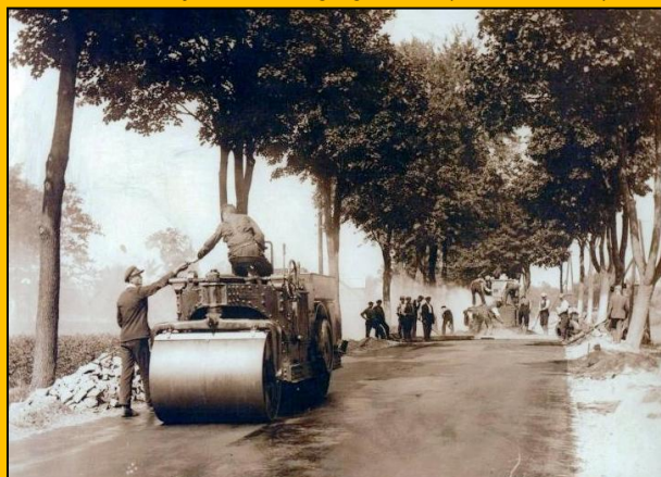
Fot. Asfaltowanie drogi pszczyńskiej w 1930 roku
