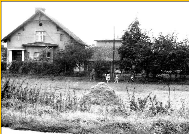
Fot. ul. Kobiórska -1983r. Budynek „Myta” (leśniczówka)
