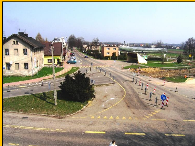
Fot. Budowa „ronda” – 2006r
