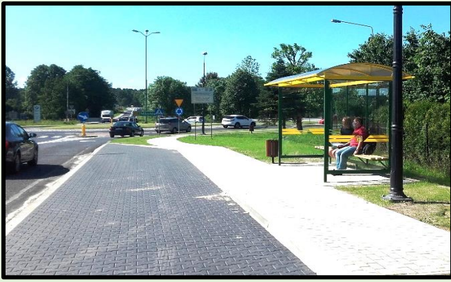
Wykonanie nowej zatoki autobusowej wraz z wiatą przystankową
