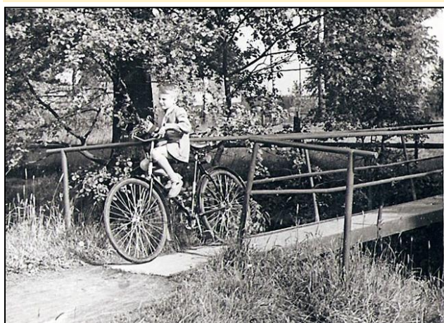
Fot. Kładka betonowo-stalowa „ława”, na ścieżce Bajcara -1954
