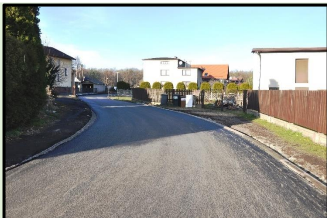
Przebudowa nawierzchni ul. Wodnej
