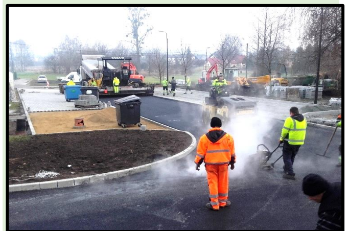
Wykonanie parkingu przy ul.Centralnej 57
