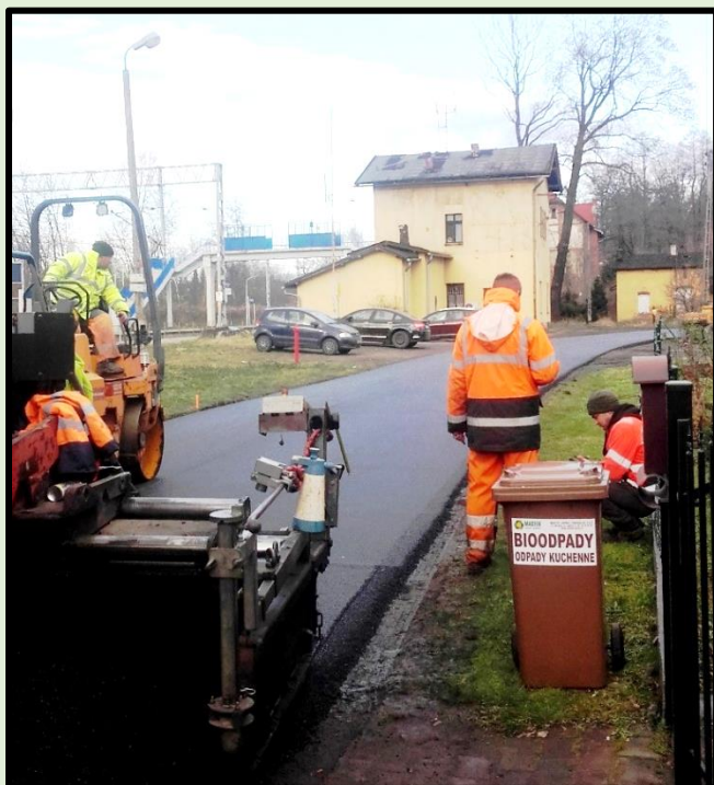
Przebudowa nawierzchni ul. Żelaznej
