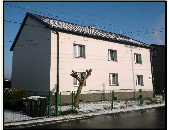
Termomodernizacja budynku komunalnego przy ul.Tuwima 32 w Kobiórze
