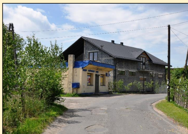
Fot. Kiosk z nowym budynkiem handlowo-mieszkaniowym w budowie - 2012
