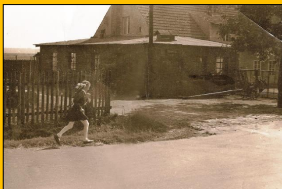
Fot. Zjazd i kuźnia od strony północnej - 1958 Fot. z prawej: Kuźnia przed rozebraniem - 1998
