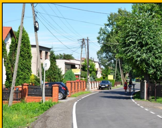
Fot. ul.Ołtuszewskiego - skrzyż. z ul.Południową - 2016
