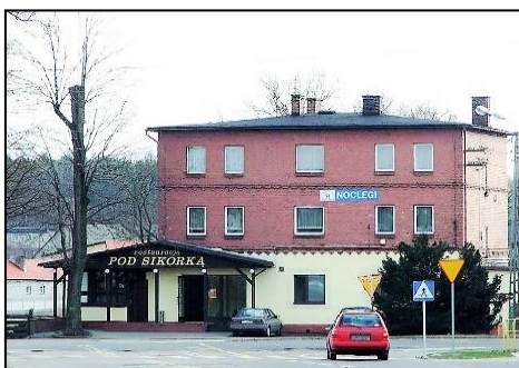
Fot. Elewacja frontowa - 2002
