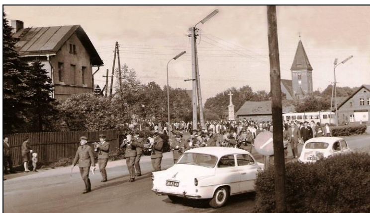
Fot. Widok na budynek mieszkalny po gospodzie Samuela Köenigsfelda - 1968
