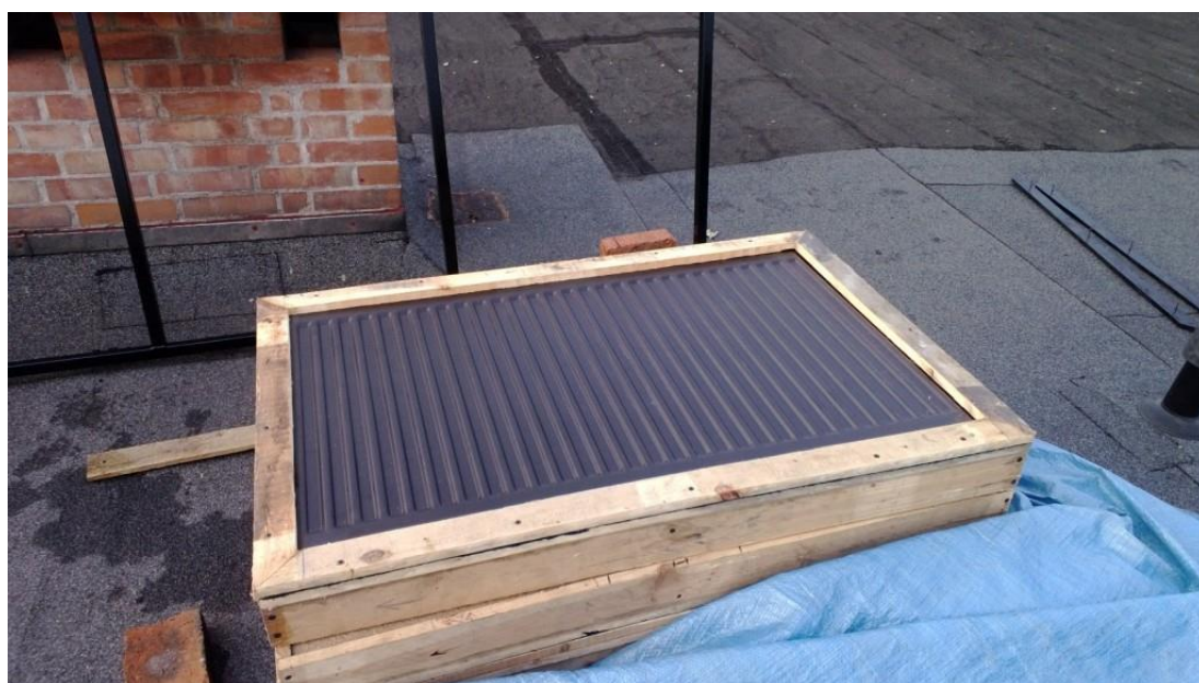
Kolektor “grzejnikowy” w trakcie budowy
